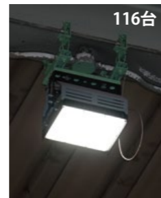
高天井用LED照明 DRGE17H21K/ND-PJX8 平均消費電力:99W
