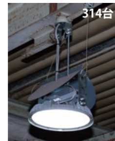
高天井用LED照明 DRGE17H24G/N-PJX8HK-S 平均消費電力:94W
