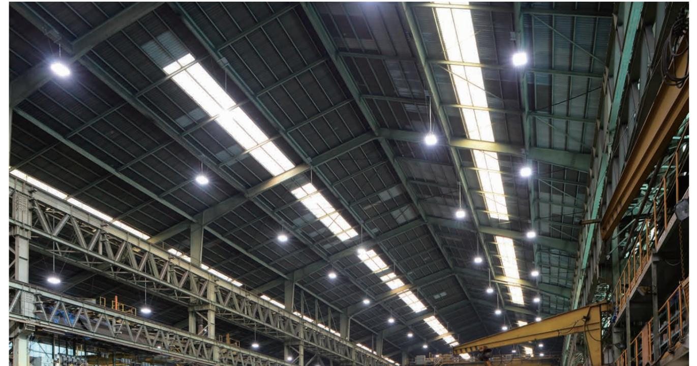
産機大型工場は天井高が約22mあり、クレーンによる遮光の問題改善と作業面の要求照度300lxを実現するため、現場での打合せと実機サンプルによる検証を重ねました。設置に使用する部品等のフォローも行い、落下防止に関するお客様の不安を解消しました。
