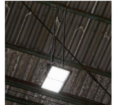
九州事業所敷地内にある関係会社の工場もLEDにリニューアルしました。天井高約8mで、効率的に作業面の明るさを確保するため、中角配光の高天井用LED照明器具を納入しました。
