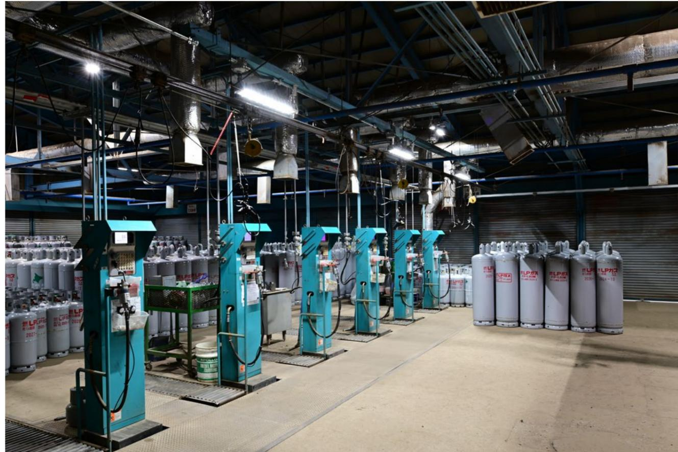
札幌市に立地するLPガスの充填所が、防爆形照明を水銀灯と蛍光灯からLED光源の照明に更新されました。改修にあたり、200形水銀灯が使われていた高天井形の器具は、器具の直下付近とその他の場所の明るさムラが大きく、改修にあたっては一部の高天井照明を横長の蛍光灯代替形に変更することで充填所内に均一な明るさが広がるようになり、器具位置の調整で器具の新設と撤去を行い、無駄なくムラのない明るい環境に改善することができました。長寿命なLED照明の導入でランプ交換の手間が削減され、明るさがアップして視認性も向上し安全性が高まりました。電力使用量は約75%の削減が見込まれています。
