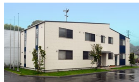
高圧ガス工業株式会社 広島工場
