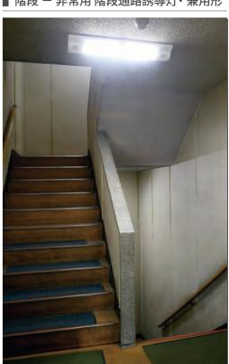
電波式センサですばやく人を検知して30% 点灯から100%点灯に自動切り替え。LED化と 人感センサのダブル効果で、電気代を大きく 削減します。
