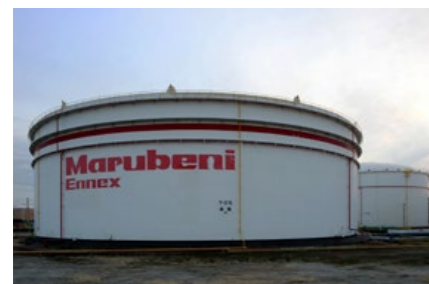
丸紅エネックス株式会社 堺ターミナル 大阪府堺市西区築港新町2丁2番地
