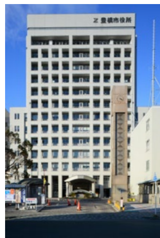
豊橋市役所 愛知県豊橋市今橋町1番地
