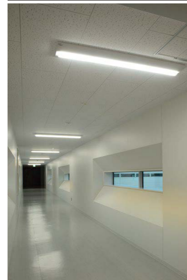
■ 館内通路 LED一体型ベース照明
