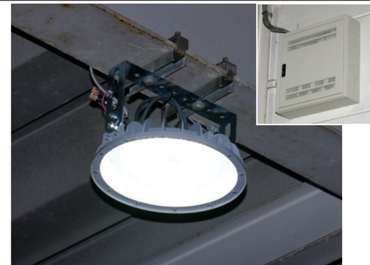
電源別置型器具本体と電源収納ボックス(電源6台収納)
