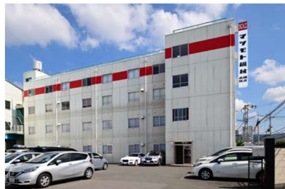
マツモト機械株式会社 本社工場 大阪府八尾市老原4-153
