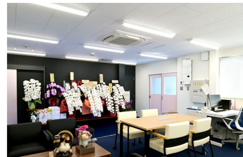
非常用LED照明器具
