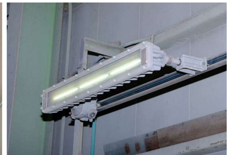
■ 防爆形LED照明器具 MGLD3H291(TB)G/N-N8
