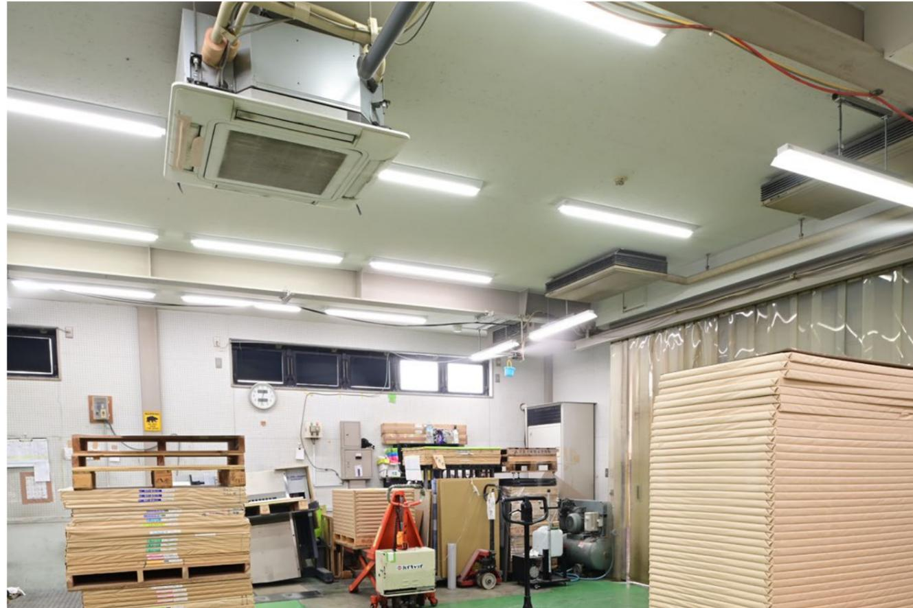
WEBサイト制作やデザインから印刷までを一貫対応する同社の品川工場は、旧東海道品川宿から3kmほど南に進んだ勝島運河や大井競馬場の近くに立地しています。従来使用していた蛍光灯器具の経年劣化も進んだことで、省エネ化設備の導入助成金を活用してLED照明器具への更新を実施されました。従来は印刷工場特有の正確な色彩表現力に対応する色評価用蛍光灯が使用されていましたが、今回の改修に際しては、色の識別性が高い平均演色評価数Ra98の高演色LEDライトユニットを導入。長期にわたって安定した照度を保てるようになり、照明の消費電力は従来の半分以下への低減が見込まれます。
